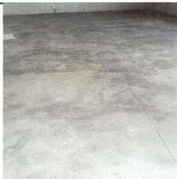
Foto 11: Sustitución de piso prefabricado por torta de concreto, en módulo 2
