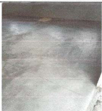
Foto 1: Sustrucción de piso prefabricado por torta de concreto, en módulo 2
