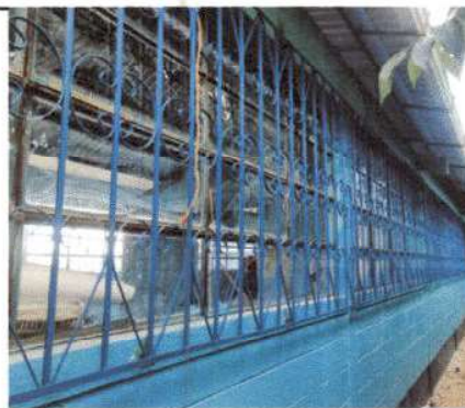
Foto 10: Fabricación e instalación de balcones de hierro en ventanas, en módulo 1
