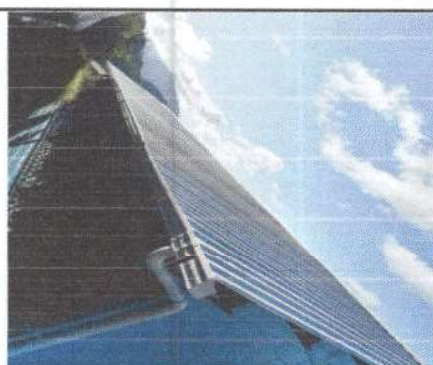
Foto 4: Sustrucción de canal pvc, en módulo 1
