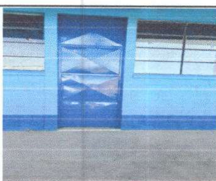
Foto 6: Mantenimiento de puertas de metal, en módulo 1
