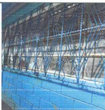
Foto 5: Mantenimiento a balcones de metal, en módulo 2
