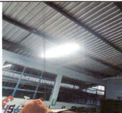
Foto 8: Sustitución de lámpara de 2 x 40, en módulo 1
