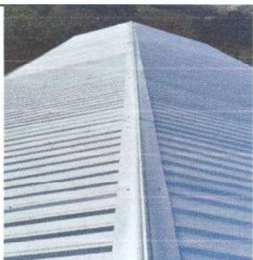
Foto 3: Sustrucción de lámina, por lámina troquelada aluzinc calibre 26, en módulo 1
